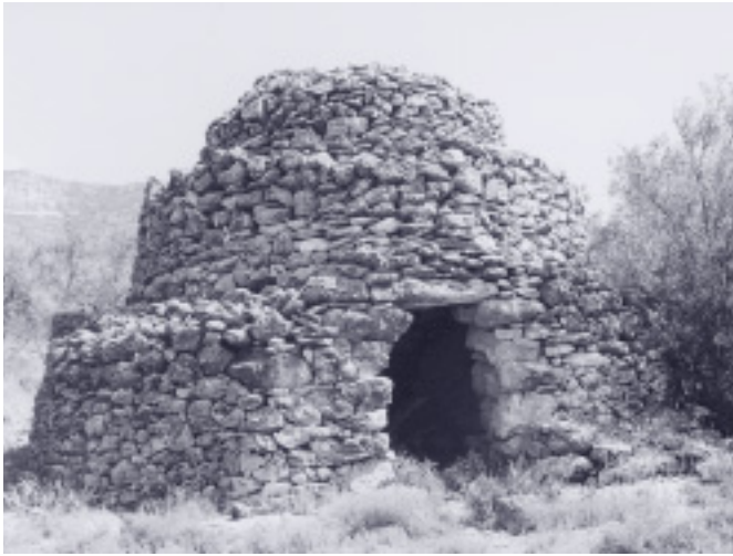
El Montsià. Barraca de parets retranquejades i portal de llinda.
