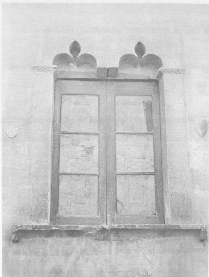
Finestra geminada d'estil gòtic tardà a la façana de l'abadia.
