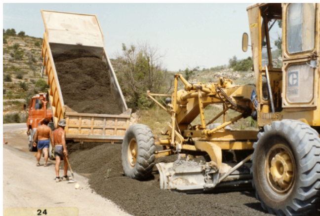
Reforç experimental de formigó en sec compactat a la TV-2042, de Masllorenç a Masarbonès (PK 4+360 i PK 7+085). Abocament de la càrrega d'un camió. Autor desconegut. Any 1986. AGDT 0047844.
