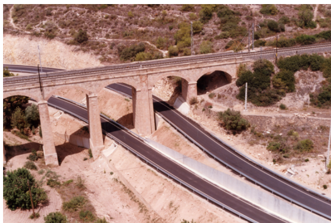
Condicionament de la carretera N-340 a la TV-2042, per Roda de Berà i Bonastre (TV-2041). Autor desconegut. Any 1989. AGDT 0048648.0047155.
