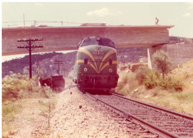
Pont sobre el riu Ebre a Vinebre-Ascó. Autor: Crescenti. Any 1974. AGDT 0047127.
