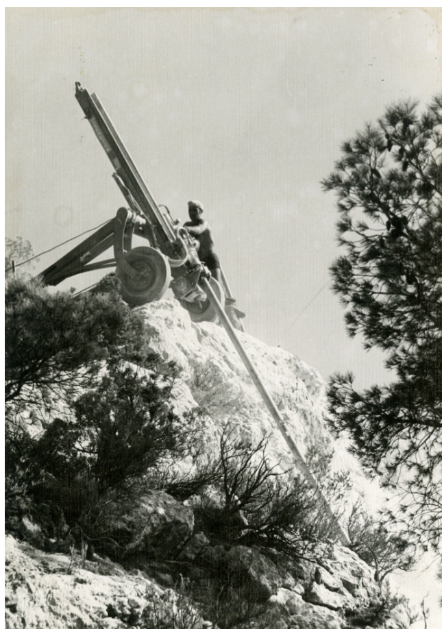
Obres a la carretera de Móra la Nova a Ascó per Garcia (C-12). Autor desconegut. Any 1970. AGDT 0046773, 0046793.
