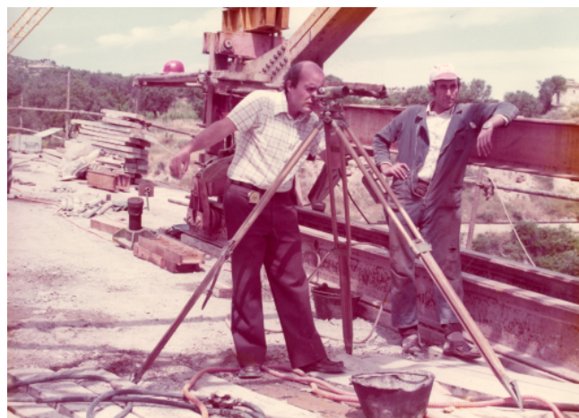
Pont sobre el riu Ebre a Vinebre-Ascó. Autor: Crescenti. Any 1974. AGDT 0047093, 0047120.
