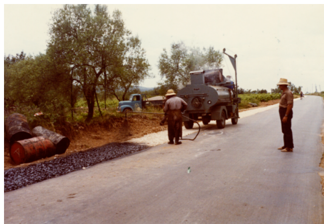
Ampliació de la calçada en una carretera provincial a càrrec d'una brigada del servei (1972-1973). Autor: Vallvé. Any 1970. AGDT 0020322.
