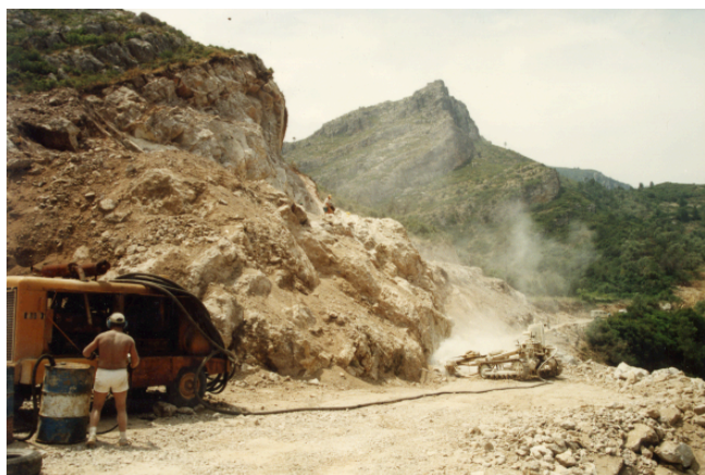
Voladures a les obres de la carretera d'Alfara de Carles. Autor desconegut. Any 1994. AGDT 0049430.
