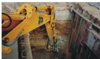
DEMOLICIÓN MECÁNICA EN ZANJA
