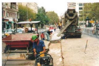
VERTIDO DE HORMIGÓN DE FIRME
