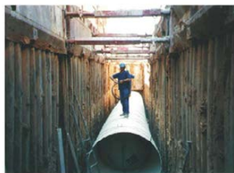
COLOCACIÓN TUBERÍA DE PVC. (RIB-LOC)
