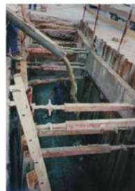
VERTIDO DE HORMIGÓN DE RECUBRIMIENTO
