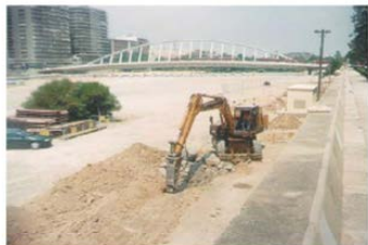
DEMOLICIÓN MECÁNICA A CIERTO ABIERTO
