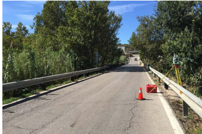
Treballs de camp i presa de dades a la carretera T-1050 a la Sénia.
