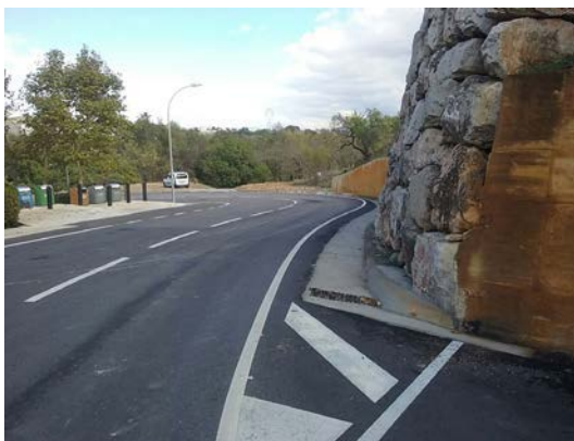
Formigonat de cuneta a la carretera TV-2232, als Garidells, i millora del drenatge.
