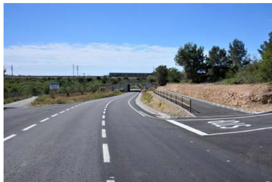
Condicionament de la travessera de la Pobla de Montornès. Carreteres T-210 i T-211.
