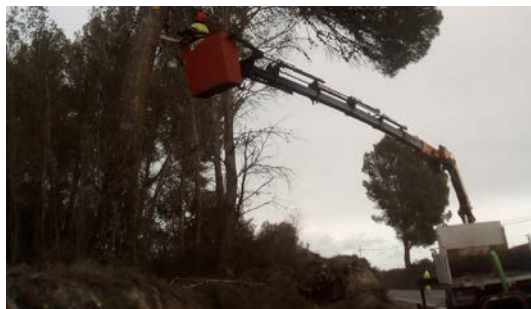
Actuació a la carretera T-751, PK 1+600, a Vallmoll.
