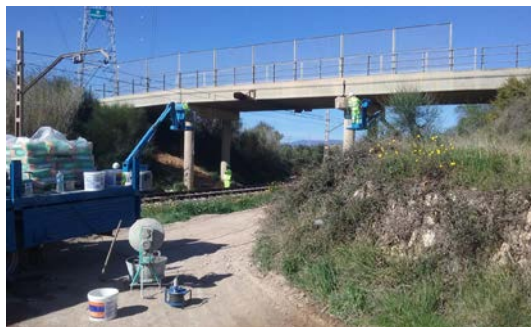
Reparació de l'estructura del pont a Vistabella, TV-2032, PK 1+337.
