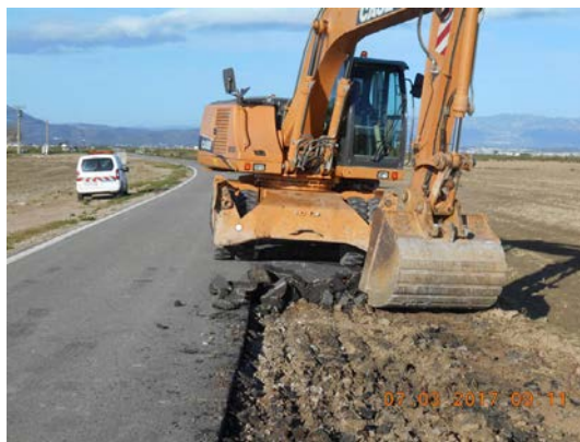
Reparació de flonjall a la carretera TV-3406, PK 9+800, a Sant Jaume d'Enveja.
