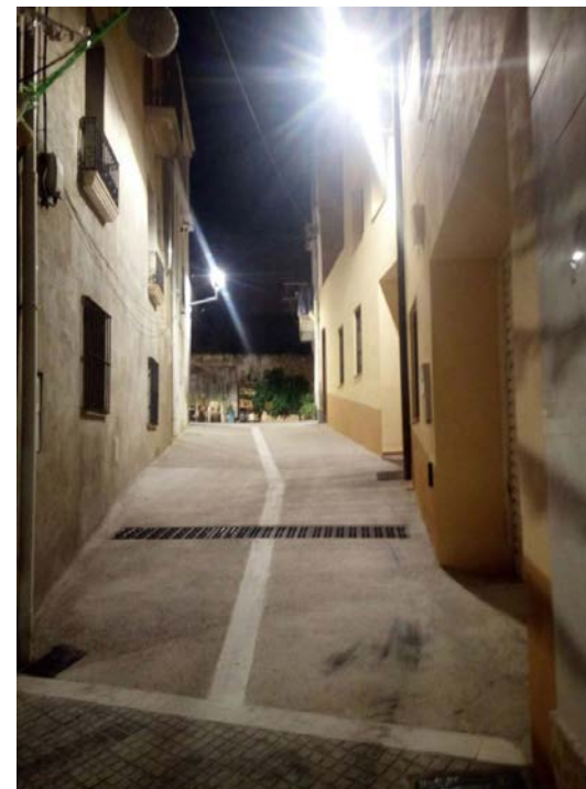
Direcció d'obres i coordinació de la seguretat i la salut del projecte "Remodelació plaça Major" de Godall.
