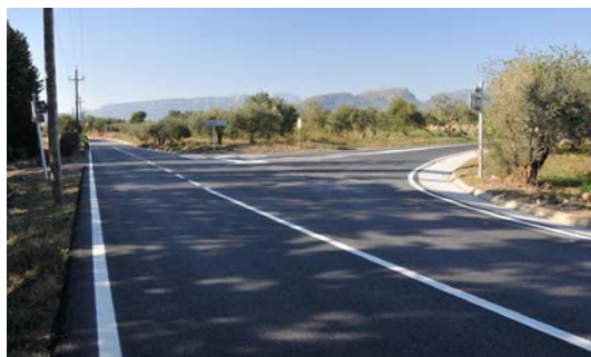
Reparació del paviment amb mescla bituminosa en calent a la carretera T-321 entre Mont-roig del Camp i Vilanova d'Escornalbou.
