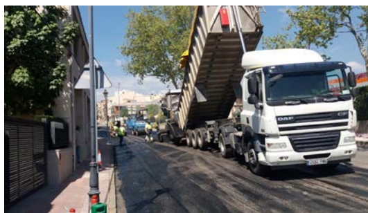
Reparació de paviment a Castellvell del Camp, carretera TP-7049.
