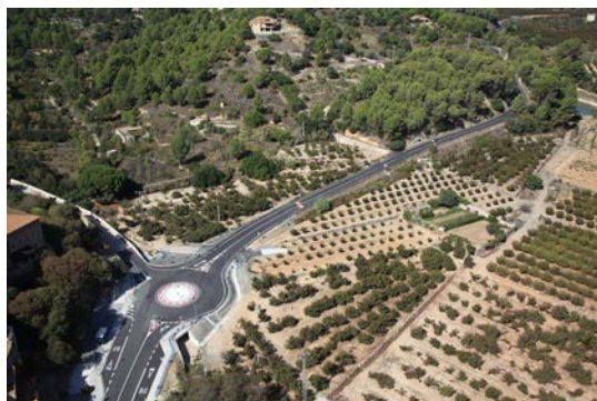
Condicionament de la carretera T-704 entre la T-11 i l'Aleixar (2a fase).
