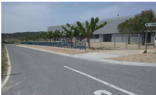
Formigonat de cuneta a la carretera TV-2021, a Vespella, i col·locació de tanca de protecció de vianants.
