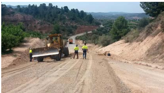
Condicionament d'un tram de la carretera T-2237 de Vinebre a la Palma d'Ebre.
