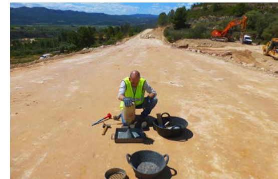
Control de qualitat de les obres de "Condicionament de la carretera T-2237 de Vinebre a la Palma d'Ebre".
