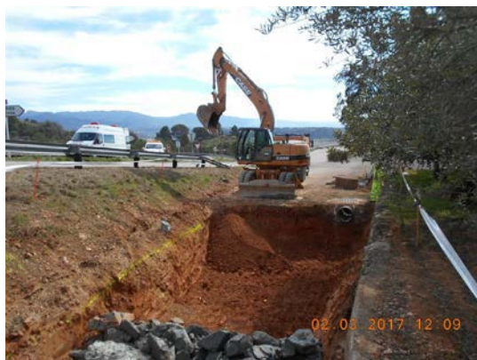
Millora del drenatge a la carretera TV-3541, PK 8, de Xerta a Paüls.
