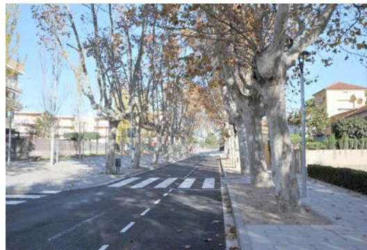
Condicionament de la travessera del barri marítim de Sant Salvador (el Vendrell). Carretera TV-2127.
