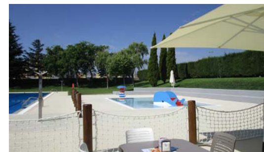
Direcció i coordinació de seguretat i salut de l'obra "Vestidors i bar piscina" al municipi de Vinyols i els Arcs.
