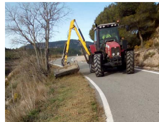
Actuació a la zona de vorals i cunetes.
