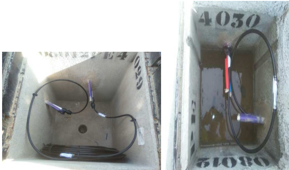
Exemples Terminació microductes en pericó
