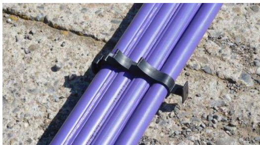
Centrador plàstic per homogenitzar la distribució del morter.
