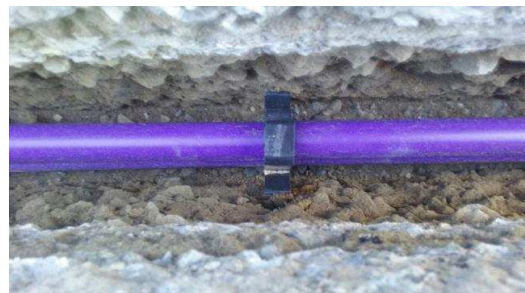
Centrador plàstic per homogenitzar la distribució del morter.
