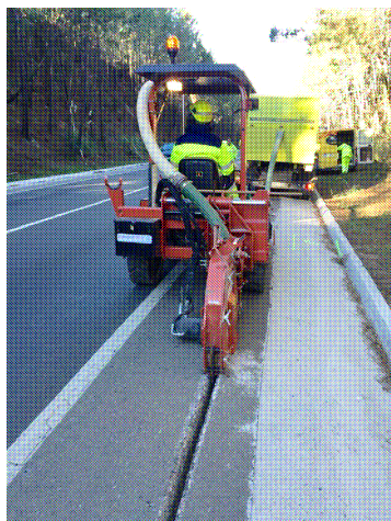
Exemple de treballs d'obertura de la microrasa
