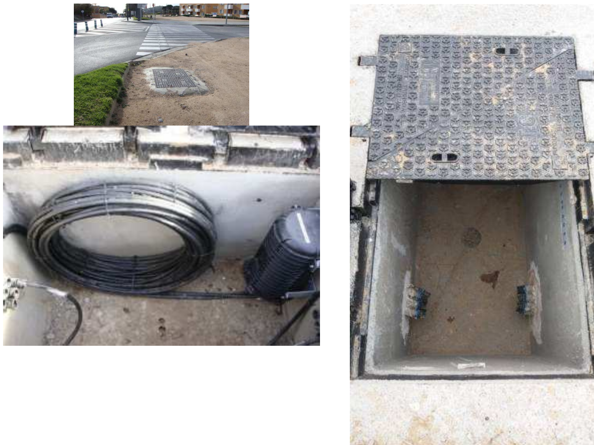
Detall interior pericons tipus C
