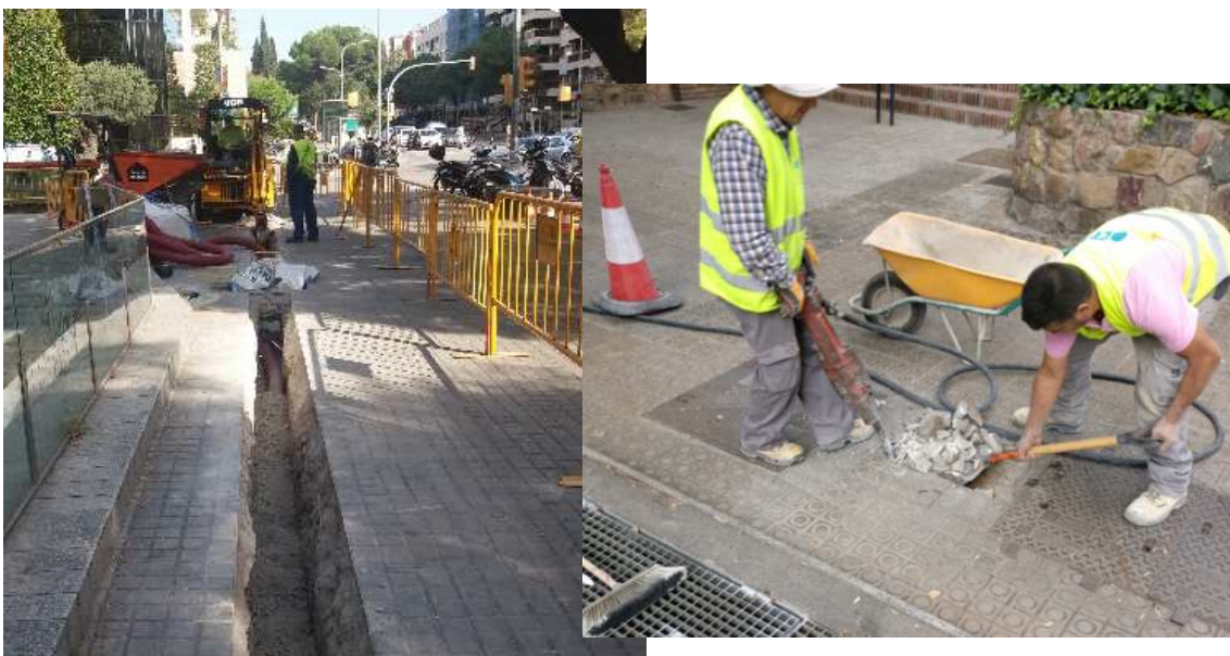
Exemples Canalització Convencional en àmbit municipal.
